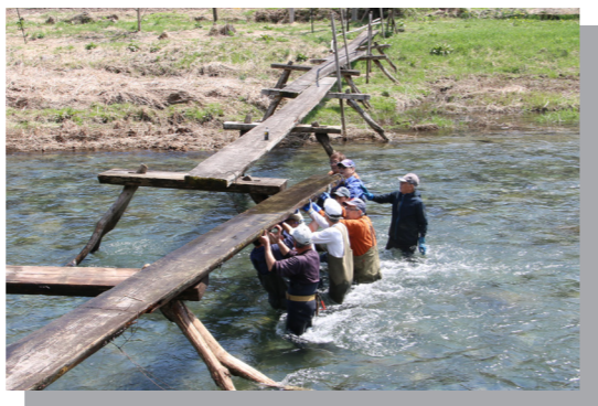
▲息を合わせながら、橋脚に橋板をのせる地域住民たち
