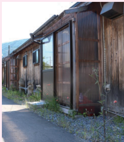
▲応急仮設住宅本町団地
