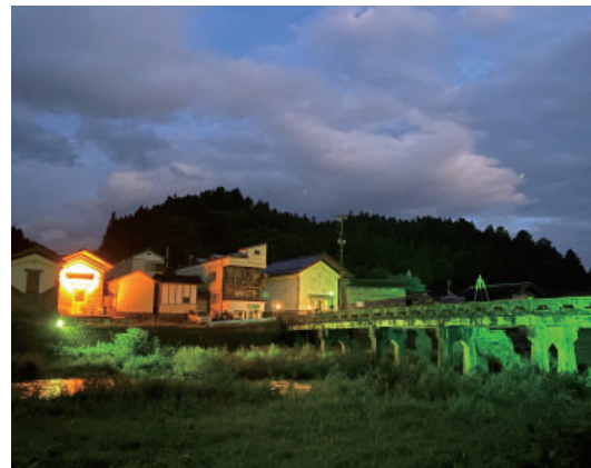
▲ライトアップされた蔵並みと昭和橋
