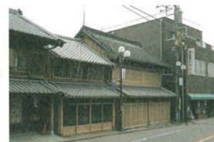
経年劣化による各部破損箇所を直し、構造補強を行いました。また、パラペット等を撤去し、正面外観を復しました。
