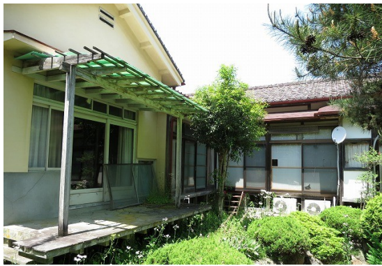
昭和32年増築部分外部
