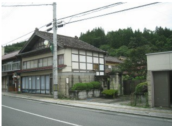
道路側町家部分外部
