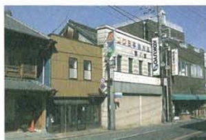
伝統的建造物の修理 (香取市佐原)
