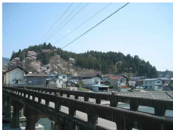
昭和橋下流側
