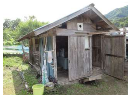
トイレ・風呂の建物
