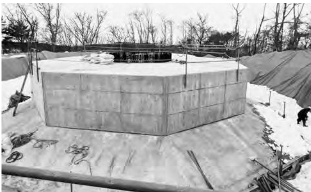
△ 風力発電の基礎工事が進む下有住字奥火の土地内
