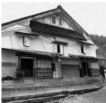
△ 耐震診断が実施される住民交 流拠点施設土蔵群
