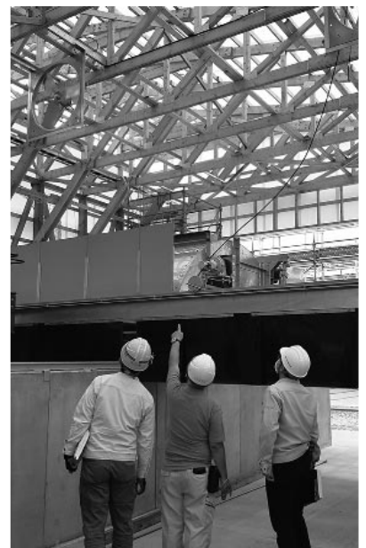
△ 建設中の鶏糞処理施設。
