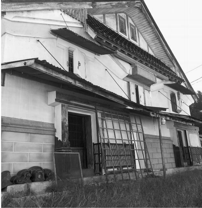
△ 「住民交流拠点施設・まち家世田米駅」敷地内の土蔵群。
