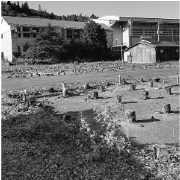
△ 仮設住宅記念行事も計画され、払い下げ撤去が進む仮設中上団地。
