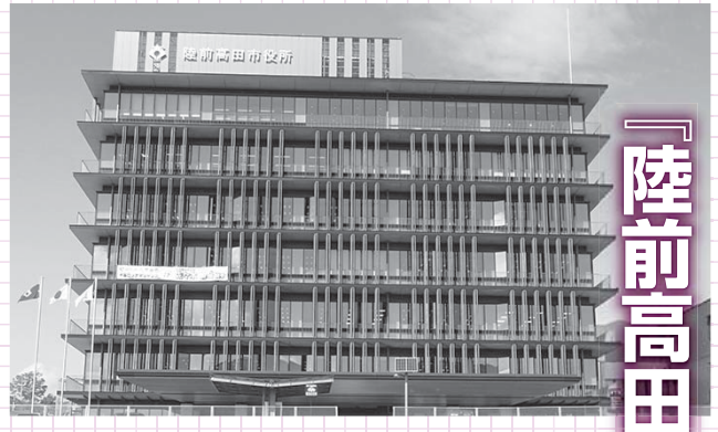
△ 新庁舎は鉄筋コンクリート造(免震)7階建て。
