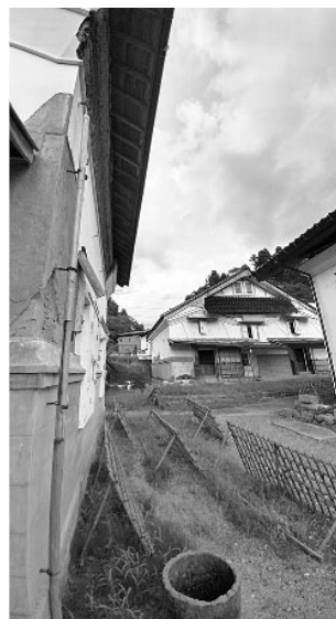
△ 改修計画のため耐震診断調査が望まれるまち家世田米駅の土蔵群。
