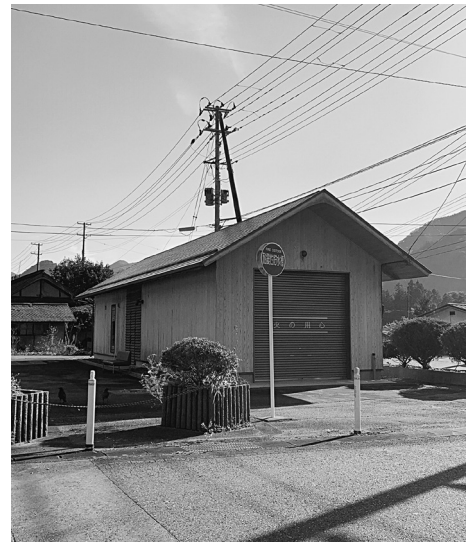
△ 消防団の活動拠点となる消防屯所
