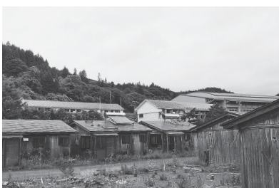
△ 解体工事を待つ中上仮設団地
