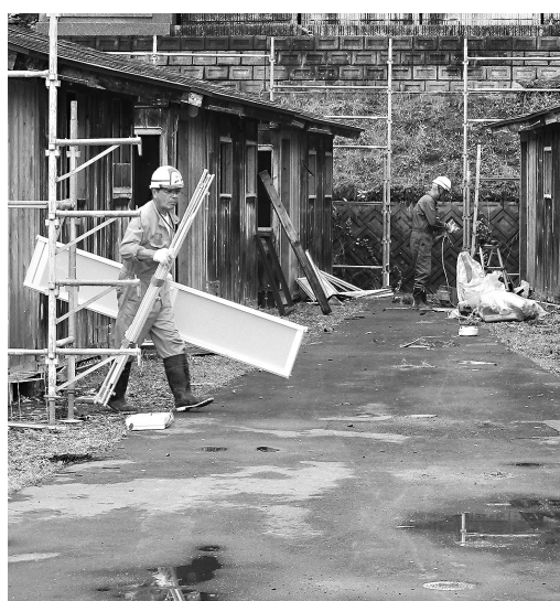
△ 解体が進む本町団地。新しく仕事や雇用を創出する、仕事・学びの場として、一体的に整備される
