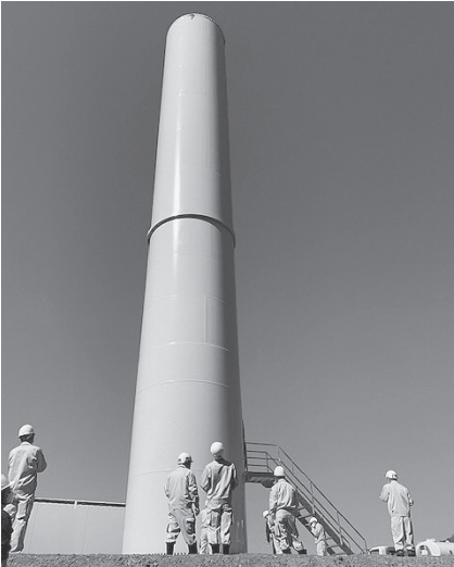
△ 直径4.6m、高さ114mのタワーが建てられています
