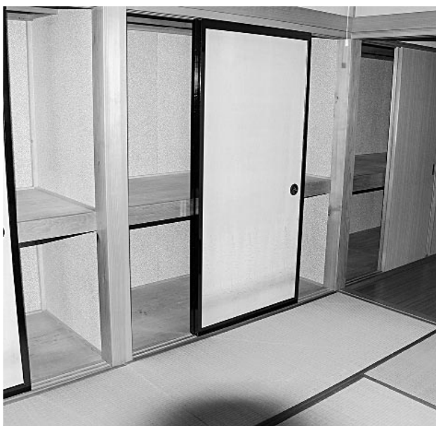
△令和元年度に手掛けた住宅改修の内装
