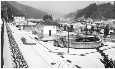
△公営企業会計に移行する下水道浄化施設
