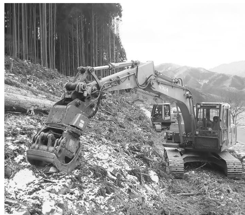
△復旧作業には、土砂、流木撤去に林・建設業の重機、オペレーターが欠かせない
