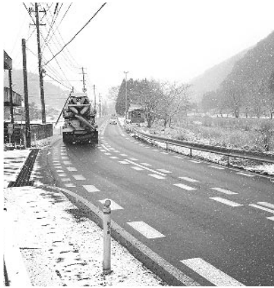
△国道と河川改修の要望が出された竹ノ原地区
