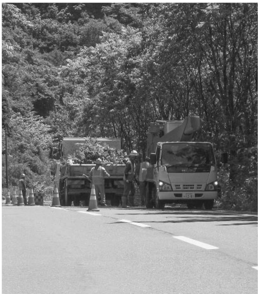
△国道397号線沿いの支障木処理作業
