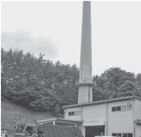
△今後解体撤去される煙突
