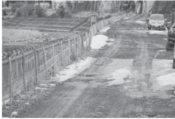
△舗装の要望があった河川管理用道路
