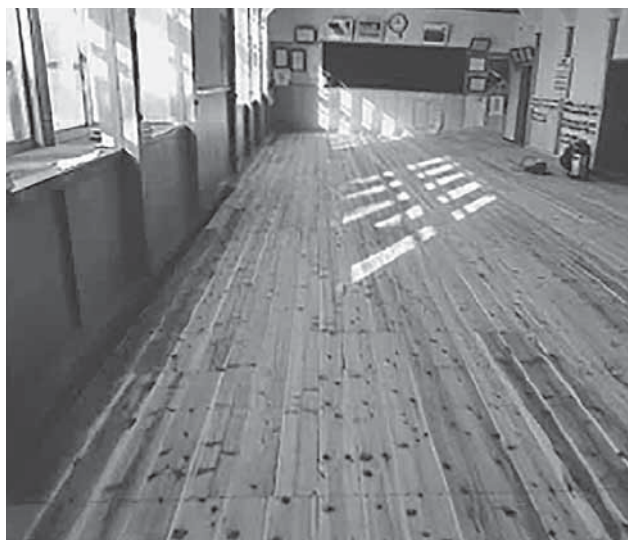
△補助制度を活用し改修された坂本自治公民館大広間
