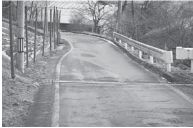
△安全を確保したい「町道小枝坂」
