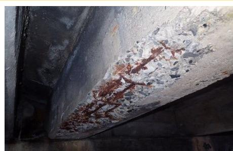
主桁の鉄筋露出
