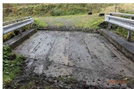
写真-3.4 土砂堆積の撤去
