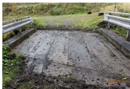
写真-3.4 土砂堆積の撤去
