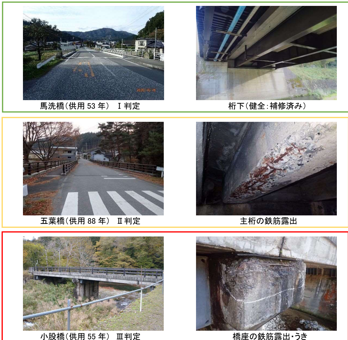
写真-3.2 各健全性区分の橋梁
