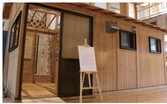
展示棟として設置する木造仮設住宅
