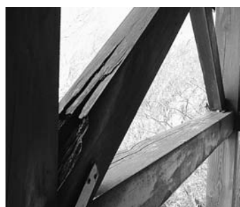
▲「しゃくなげ荘」の腐食状況
