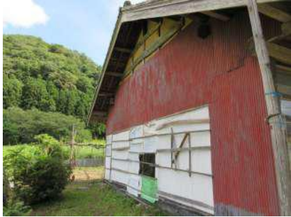
建物の北東側
