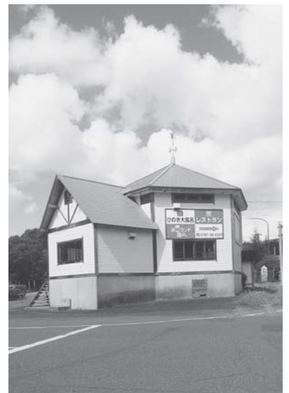
△建設から30年以上経過した(旧)道の駅
