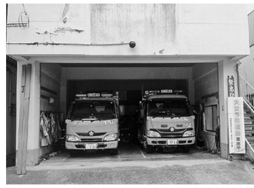
△ 改築が待たれる消防屯所
