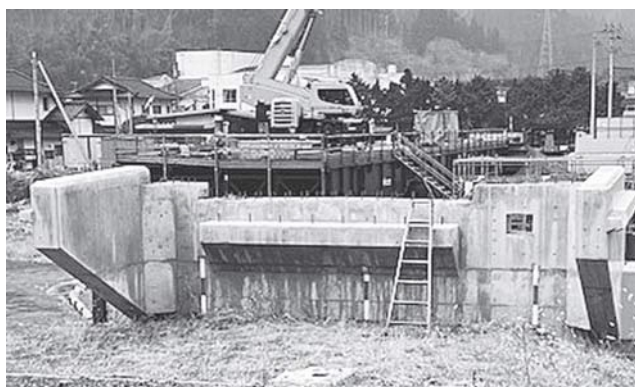
△工事中の昭和橋
