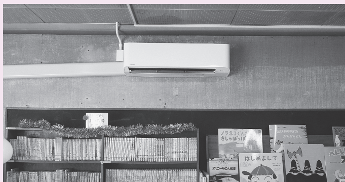
△ 旧有住中より中央公民館図書室へエアコンが移設整備された
