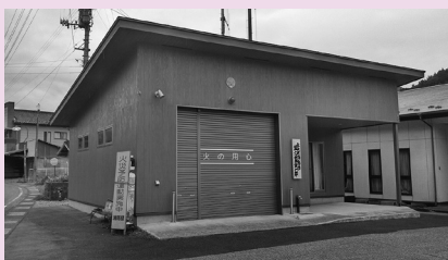
△ 外壁塗装が施された6分団1部の屯所
