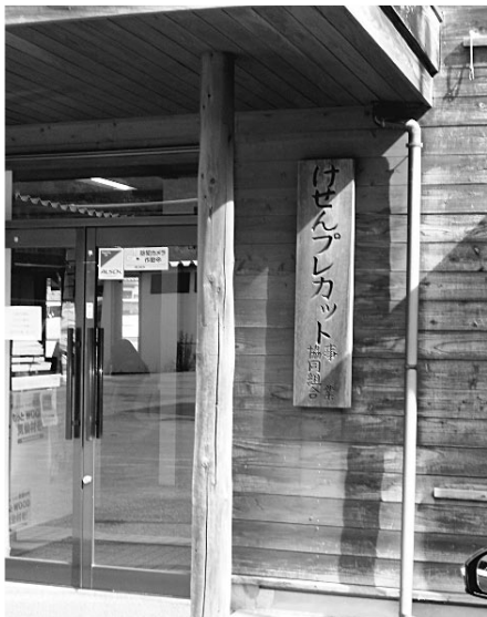
△ 事業と雇用が存続され、木工団地一体化の中核となった「けせんプレカッタ事業協同組合」。
