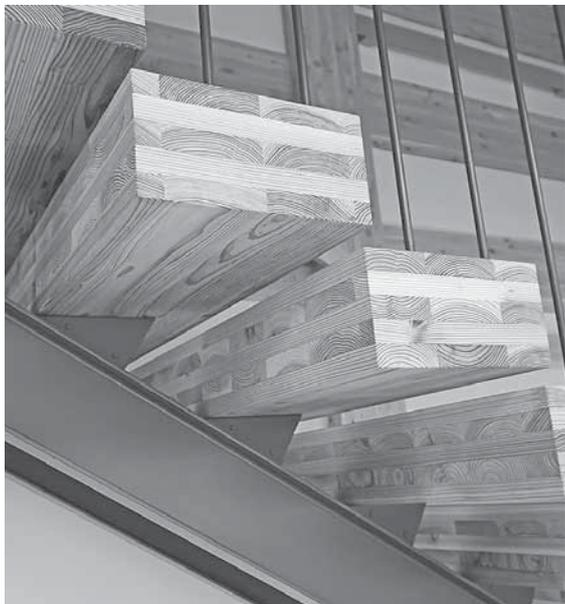
△ 防災の拠点消防住田分署階段壁面にCLT材を使用
