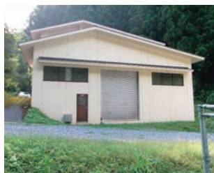
八日町浄水場
