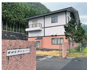
世田米浄化センター
