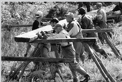
▲汗を流しながら、修復作業を進めました
