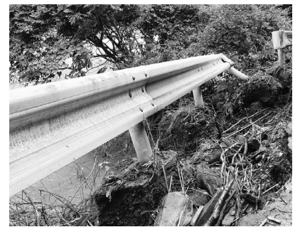
▲土砂により路肩が崩壊(上寒倉)
