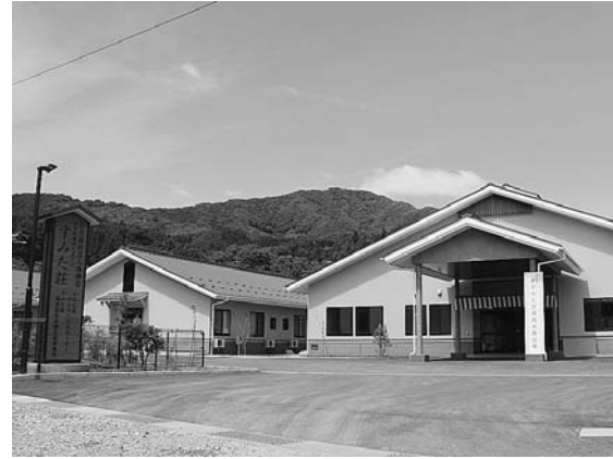
▲地域にとって念願の竣工となった新施設
