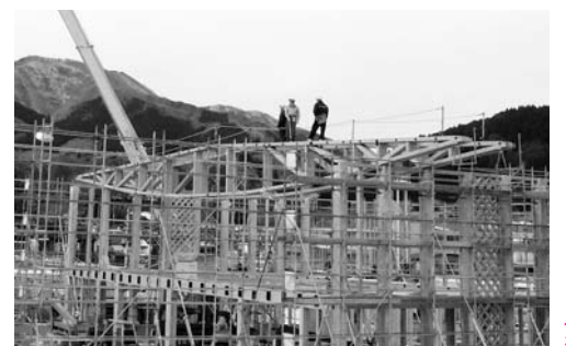
△大空間を生み出す「トラス梁」
