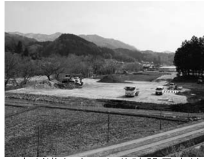
工事が進むすみた荘建設予定地
