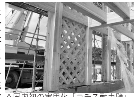
△国内初の実用化「ラチス耐力壁」
