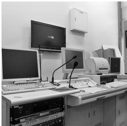
△ 改修工事が行われる町防災行政無線（固定系）施設。
