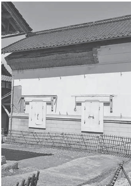
△改修予定の「まちや世田米駅の蔵」
