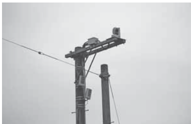
△監視の目「昭和橋付近の監視カメラ」
