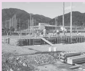
△工事が進む住田分署
