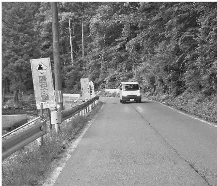
△道幅が狭く、すれ違いが困難な県道釜石住田線
