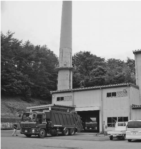
△解体される焼却施設(大船渡市猪川町)
