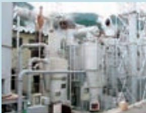
木屑焚きボイラー 1t/h (三陸木材高次加工協同組合) 2000年度
