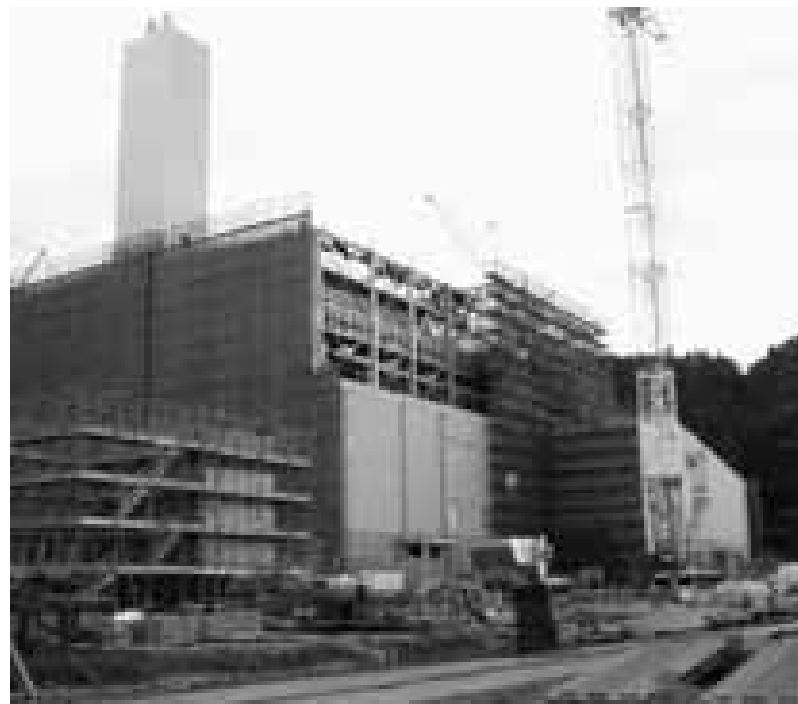
完成が間近かな「岩手沿岸南部クリーンセンター」
