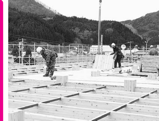
▲作業が急ピッチで進む新分署工事現場
